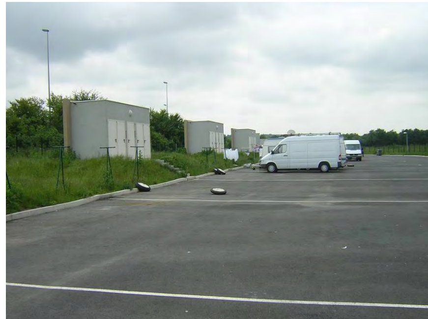
Bloc sanitaire ne permettant pas l'accès aux sanitaires en toute intimité
