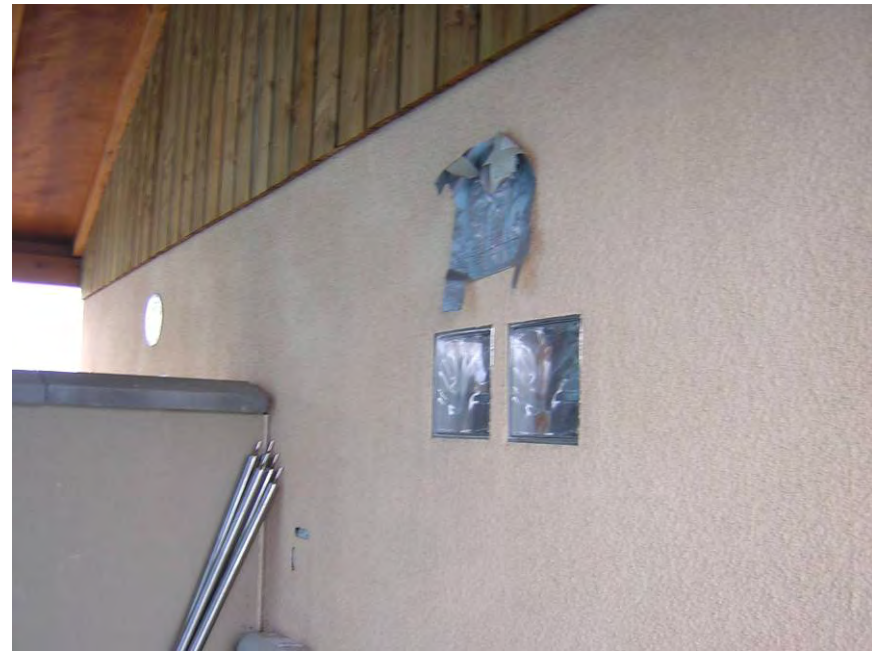
Les voyageurs bouchent les entrées de la ventilation donnant directement sur l'extérieur pour ne pas avoir trop froid lorsqu'ils se douchent
